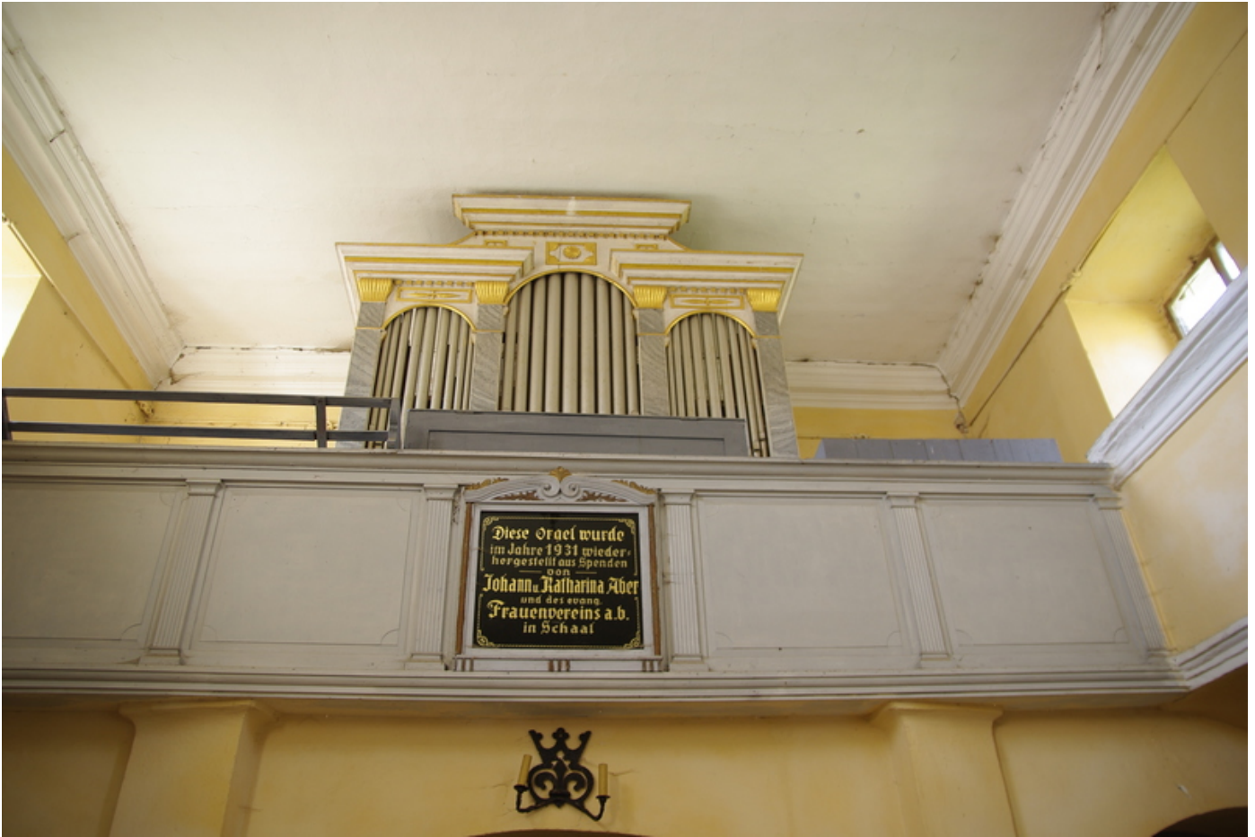
Bild vom Kirchenschiff mit Inschrift wegen der Reparatur 1931 der Orgel (wahrscheinlich die Ergänzung mit neuen Zinkpfeifen)
