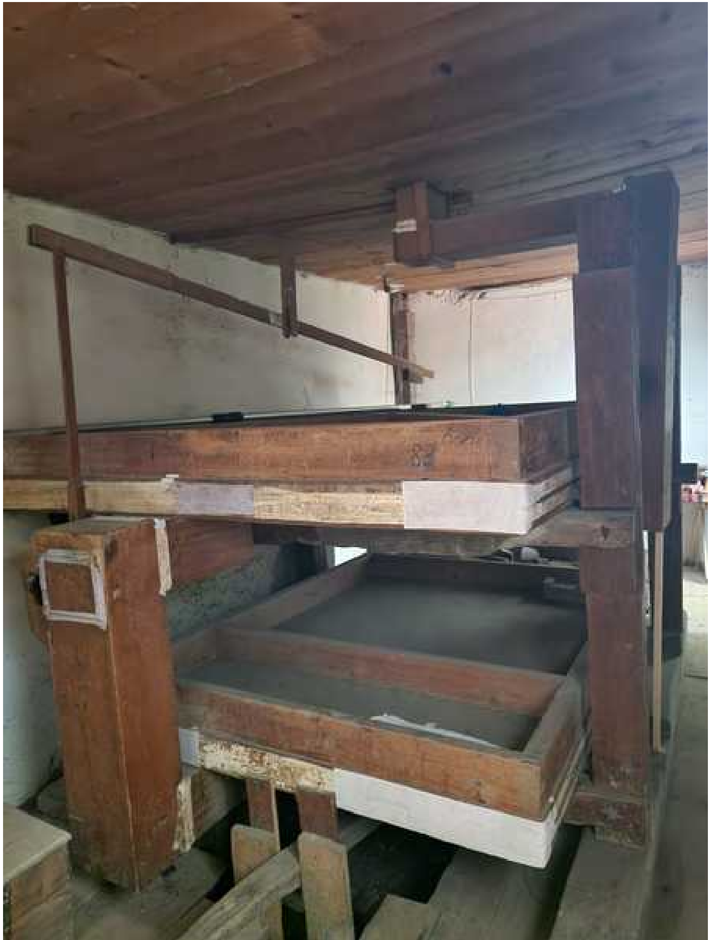
Balganlage unter der Orgel, hinter dem Altar
