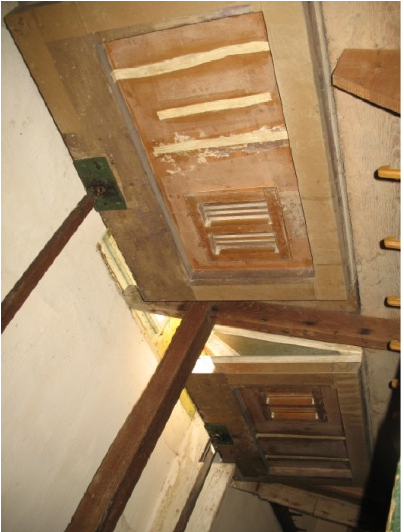
Schöpfungsbälge 1908-2013 unter dem Stimmgang, die den Magazinbalg (auf dem "Stimmgang") speisten
