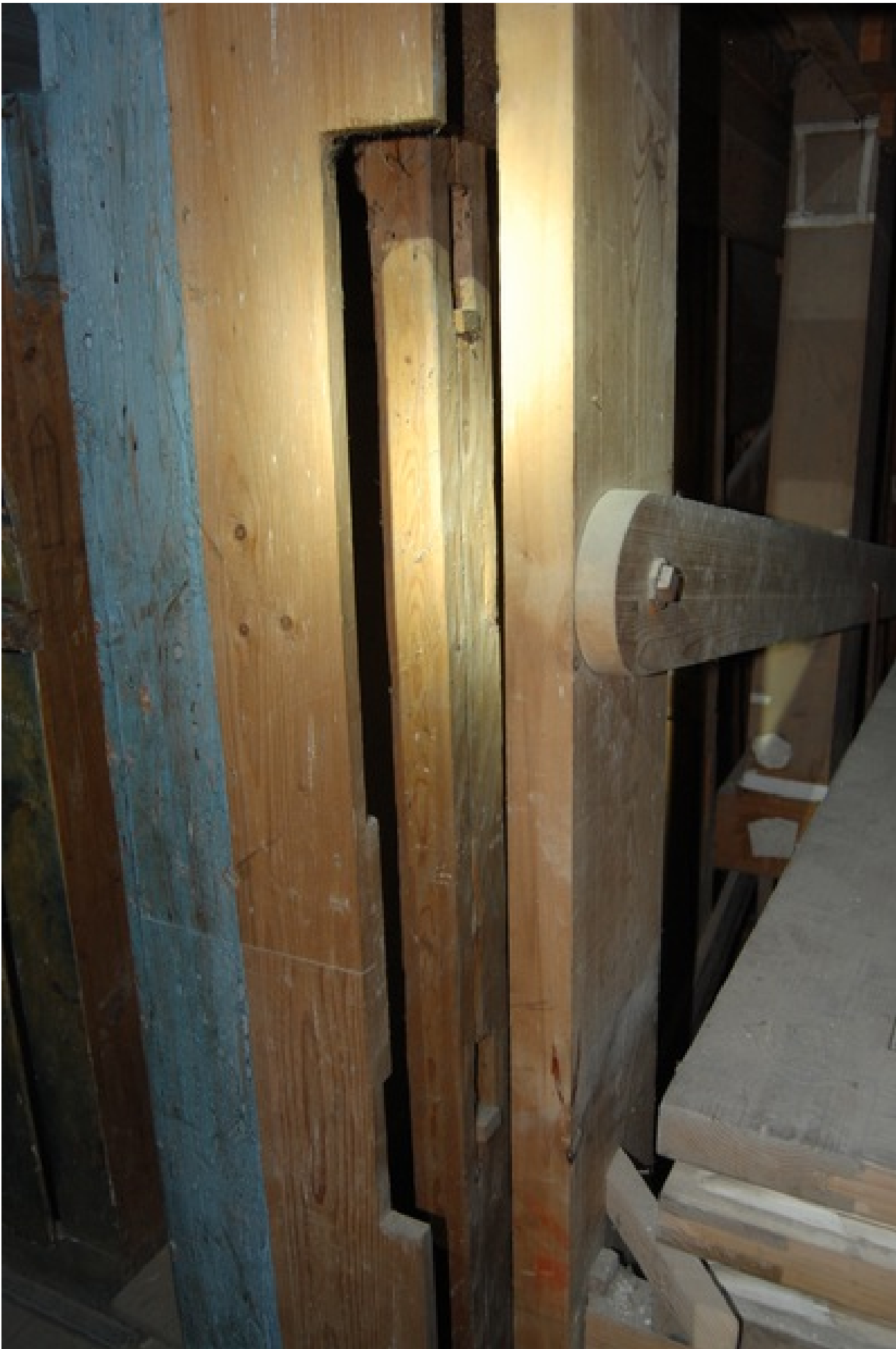
Detail der jetzigen Balganlage mit Spuren der alten Keilbalganlage links am Gehäuse Pfosten und hinten
