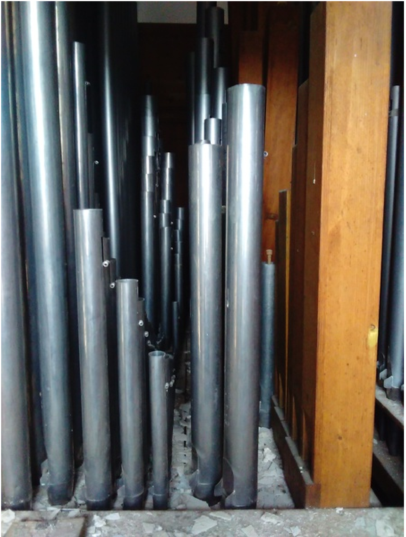
Pfeifenwerk mit Bauschutt nach der Innrenovation der Kirche, März 2016
