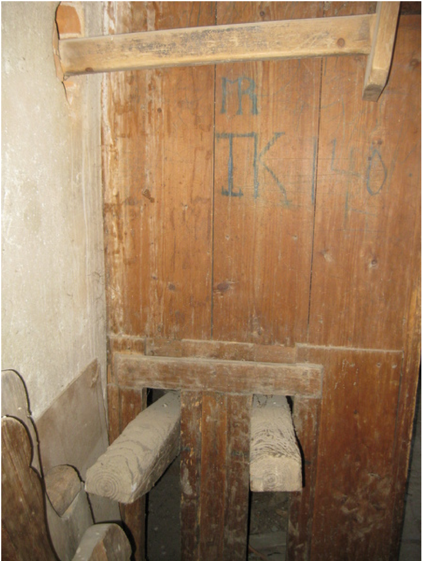
Fusstritte der Balganlage im Turmzimmer. Nicht angekoppelt; nicht restauriert
