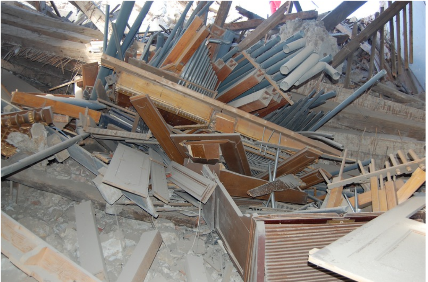
Blick vom Kirchenschiff auf die Trümmer; 22. Februar 2016
