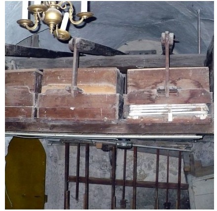
Balganlage in Sakristei
