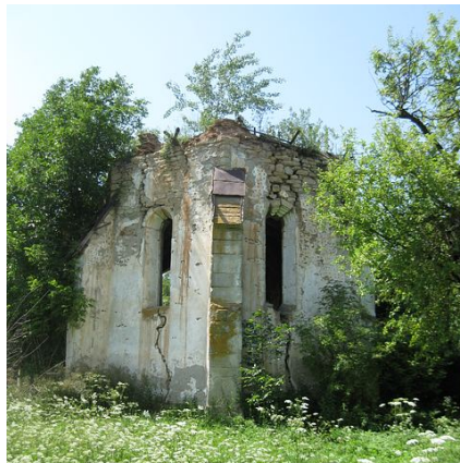
Chorraum von außen
