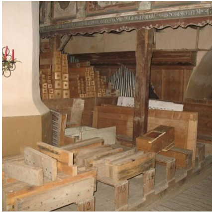
Während der Reparatur 2009
