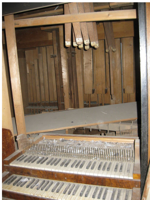
Orgel teilweise ausgebaut
