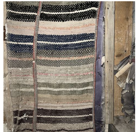
Türe zwischen Balraum und Orgelempore ist (auf der aAlraumseite) isoliert mit einer Matte
