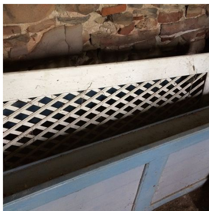
Seitenwand in einem der Wehrtürme
