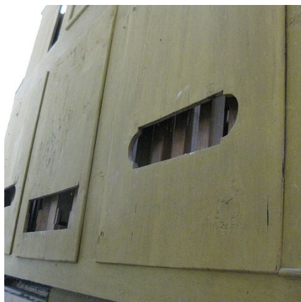
Schalllöcher in der Rückwand
