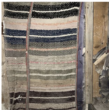
Türe zwischen Balraum und Orgelempore ist (auf der aAlraumseite) isoliert mit einer Matte
