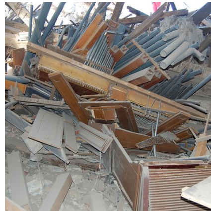
Blick vom Kirchenschiff auf die Trümmer; 22. Februar 2016
